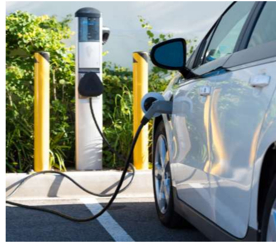
Angrenzend an das Gemeinschaftshaus werden 6 öffentliche Ladesäulen realisiert.
