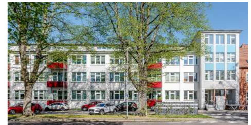
Krankenhausumbau – in Neubrandenburg
