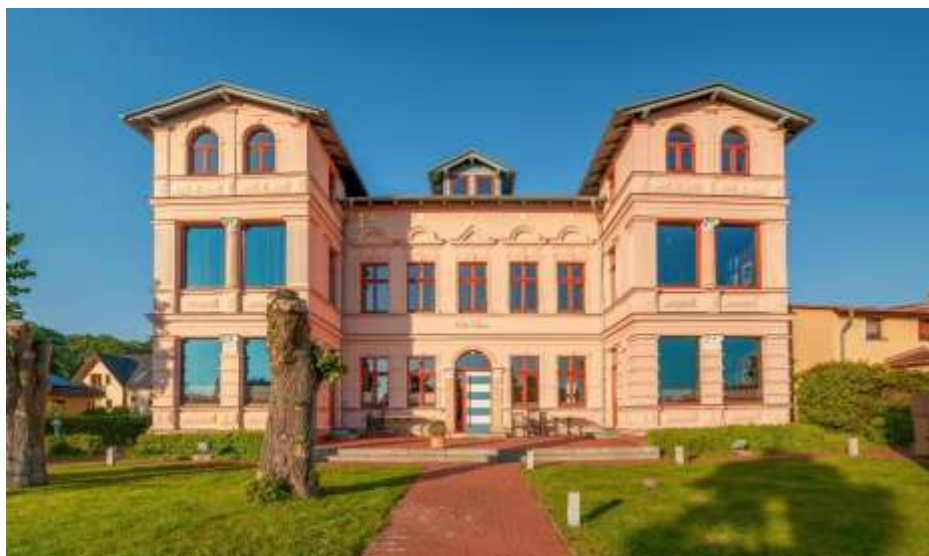
Denkmalsanierung „Villa Maria“ – in Koserow
