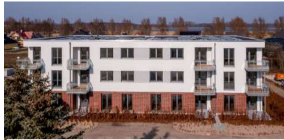
Neubau Mehrfamilienhäuser – in Peenemünde
