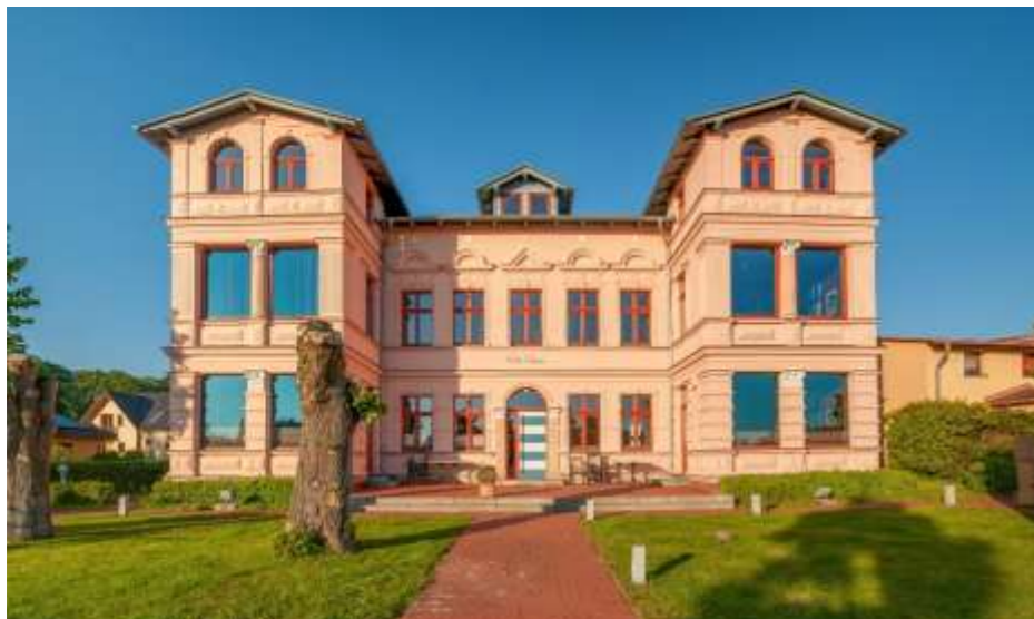
Denkmalsanierung „Villa Maria“ – in Koserow
