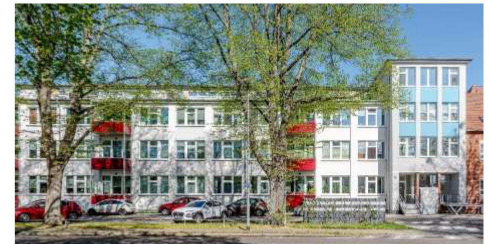
Krankenhausumbau – in Neubrandenburg
