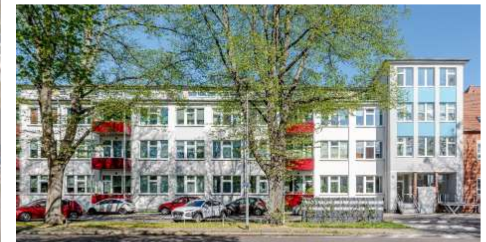
Krankenhausumbau – in Neubrandenburg
