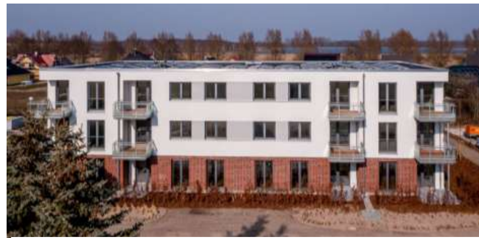
Neubau Mehrfamilienhäuser – in Peenemünde
