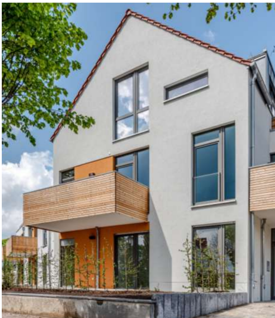
Neubau Mehrfamilienhaus – in Koserow
