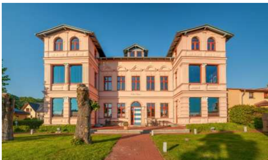
Denkmalsanierung „Villa Maria“ – in Koserow
