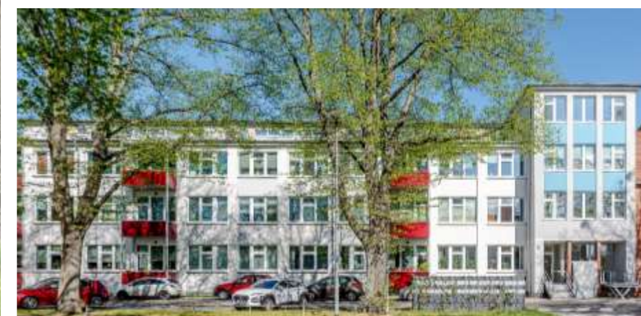
Krankenhausumbau – in Neubrandenburg
