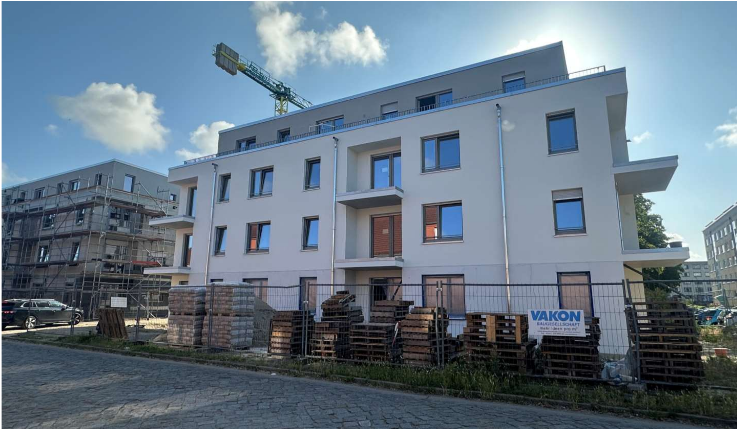
Straßenseite Baufortschritt Juni 2025
