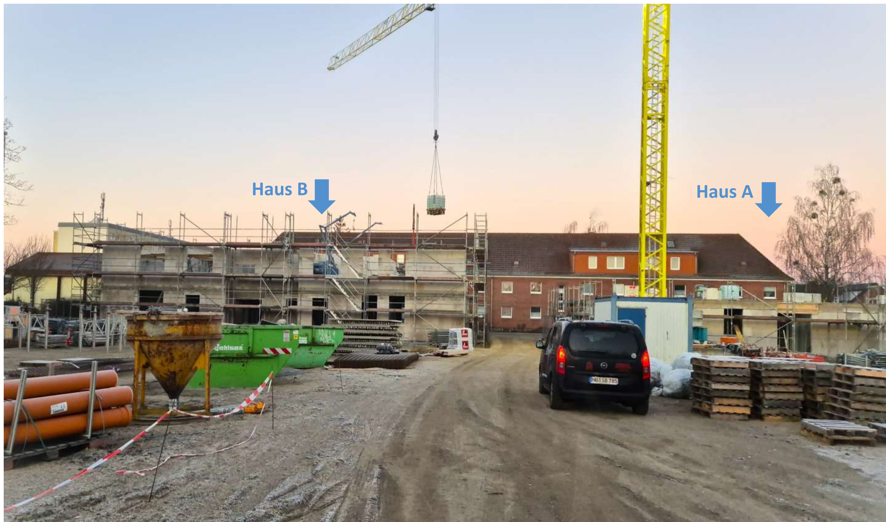
Hofseite Baufortschritt Januar 2025
