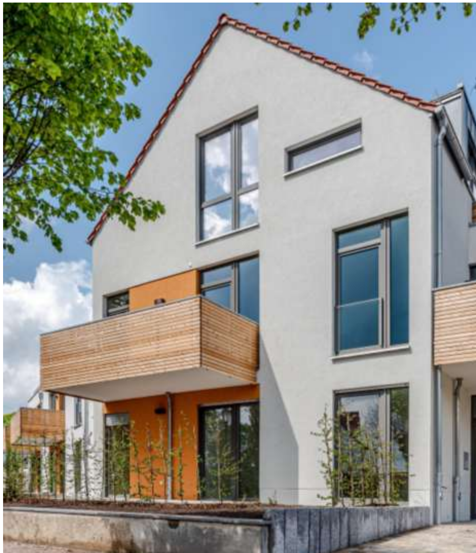
Neubau Mehrfamilienhaus – in Koserow
