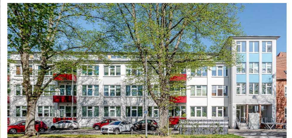
Krankenhausumbau – in Neubrandenburg
