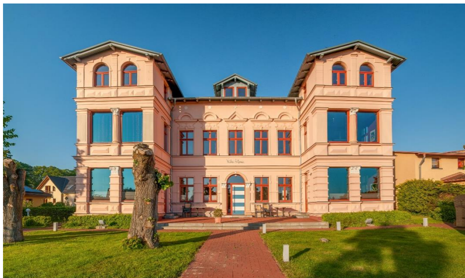
Denkmalsanierung „Villa Maria“ – in Koserow
